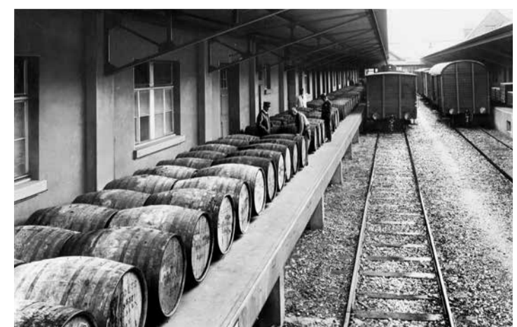
Anlieferung von 100 000 Litern Rum im Gleisfeld des Zolllagergebäudes, 1930.
